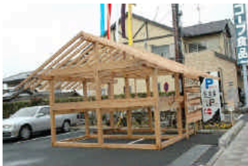
金物を使わない伝統工法の軸組み
