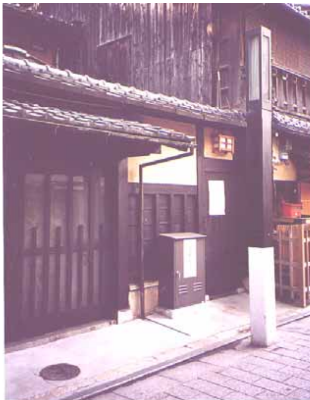
(写真) 増える私設消火栓
