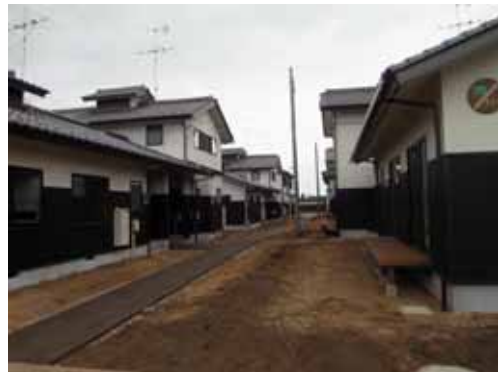
外構工事中の現地写真
