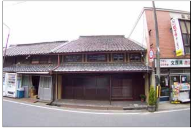
41 1階が土間で、店舗にしやすい
