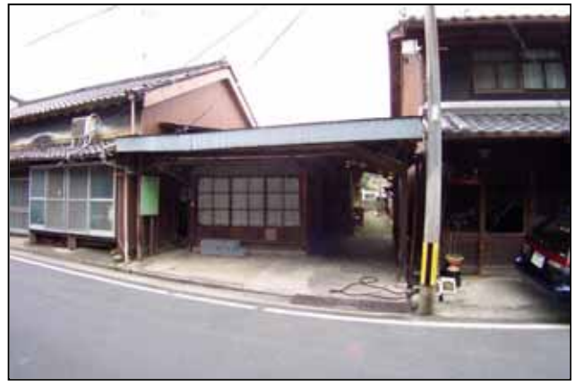
58 平屋で、元竹細工の工房だった町家
