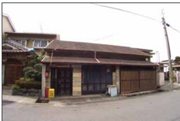
16 平屋建、屋根はスレート葺
