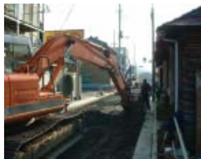
買場通り(工事中)
