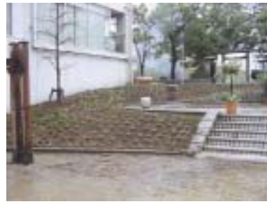
橋本町公園施工後
