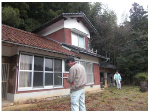
写真1 空き家外観調査
